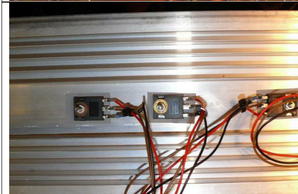
isolierte Befestigung der MOS-FETs und des 5V-Spannungsreglers auf einem Kühlkörper.
