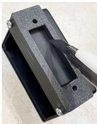
Den markierten Bereich muss man dann mit Cuttermesser oder Säge und Feile herausarbeiten:
